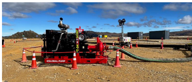
Figura 8. Motobomba inyectando solución
