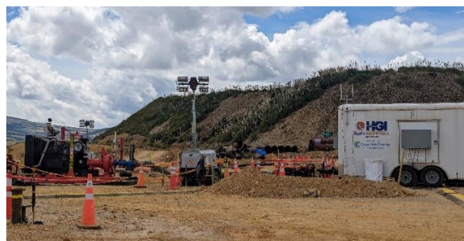
Figura 11. Monitoreo geofísico durante el pilotaje
