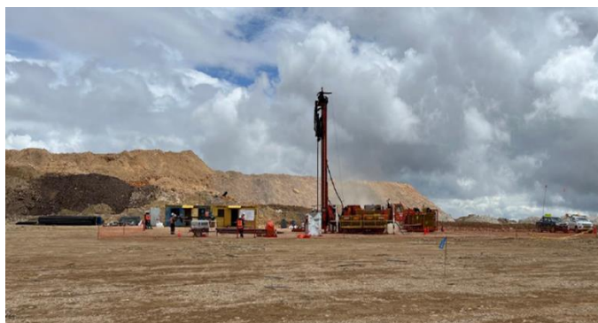
Figura 6. Inicio de la perforación en CA10
